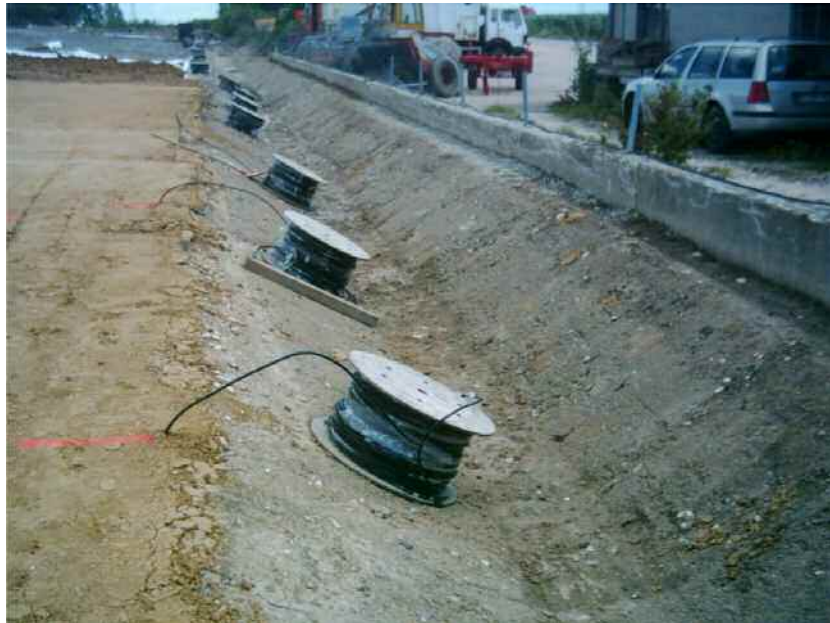
Abbildung 7 Verlegung der Messkabel unterhalb der Dichtung, Durchführung unter Randgraben
