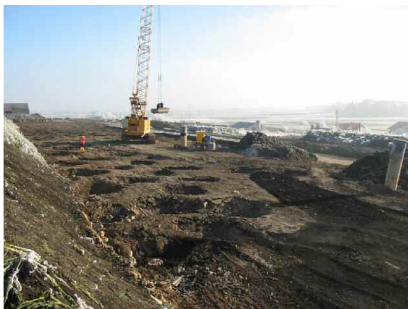
Abbildung 4 Ausführung der DYNIV im nördlichen Randstreifen der Deponie
