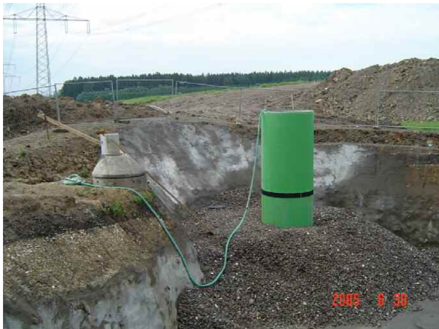
Abbildung 10 Fertiggestellter Pumpenschacht nach Verfüllung des Arbeitsraumes mit Gleisschotter
