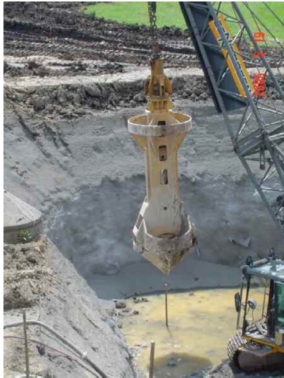
Abbildung 8 Aushub des Arbeitsschachtes mittels Bohrgreifer
