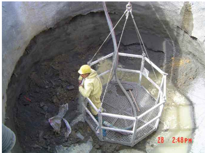
Abbildung 9 Abschnittsweise Sicherung des Arbeitsschachtes mittels Spritzbeton
